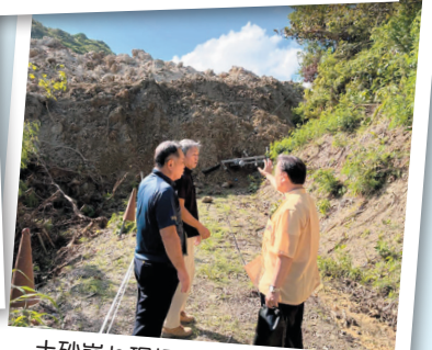
土砂崩れ現場視察 (中城村伊集)
